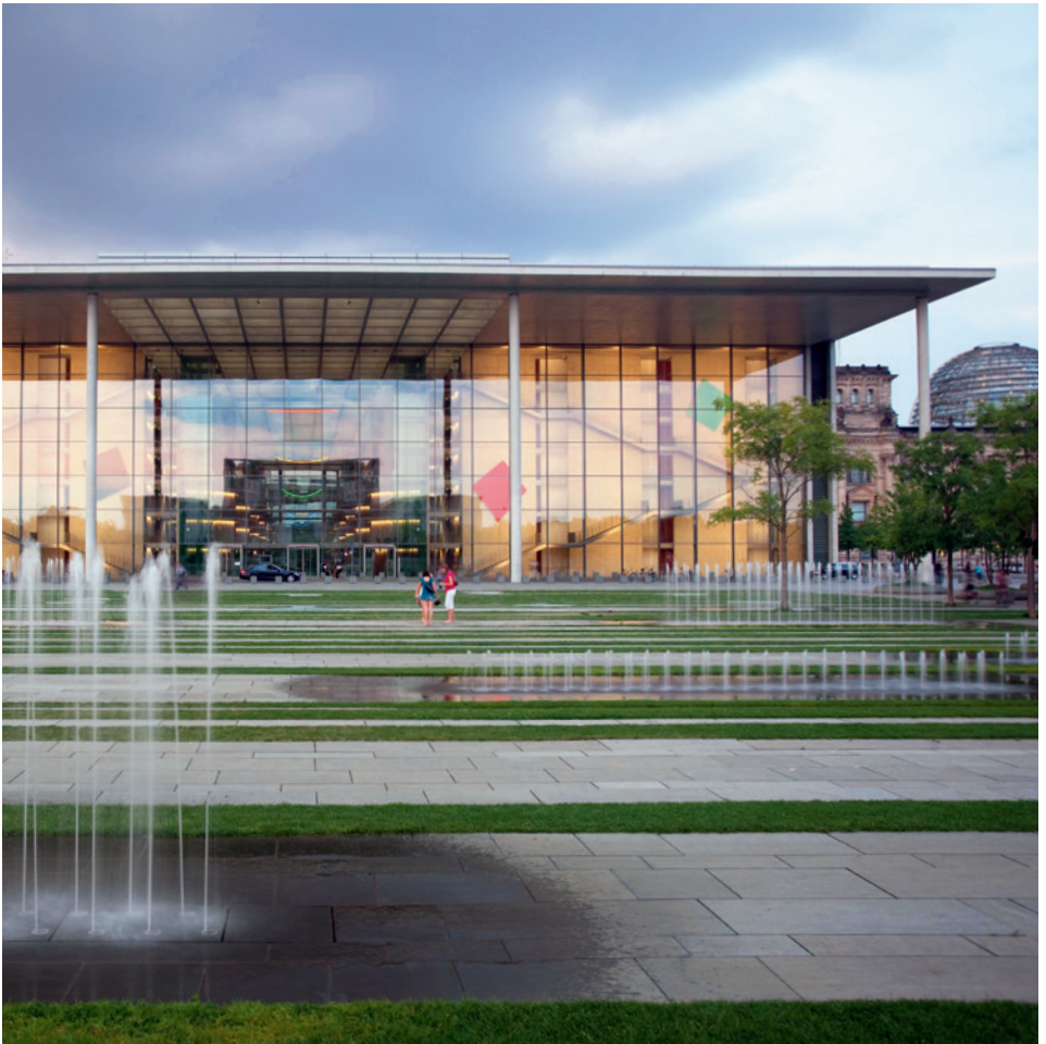
Arquitectura diáfana: entrada oeste del edificio Paul Löbe.
