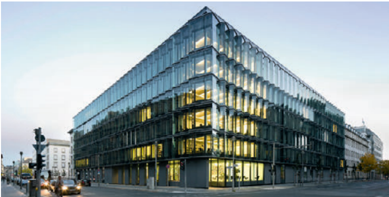
Temelden yenilendi ve ekleme yapıldı: Wilhelmstraße 65 adresindeki federal meclise ait bina.
