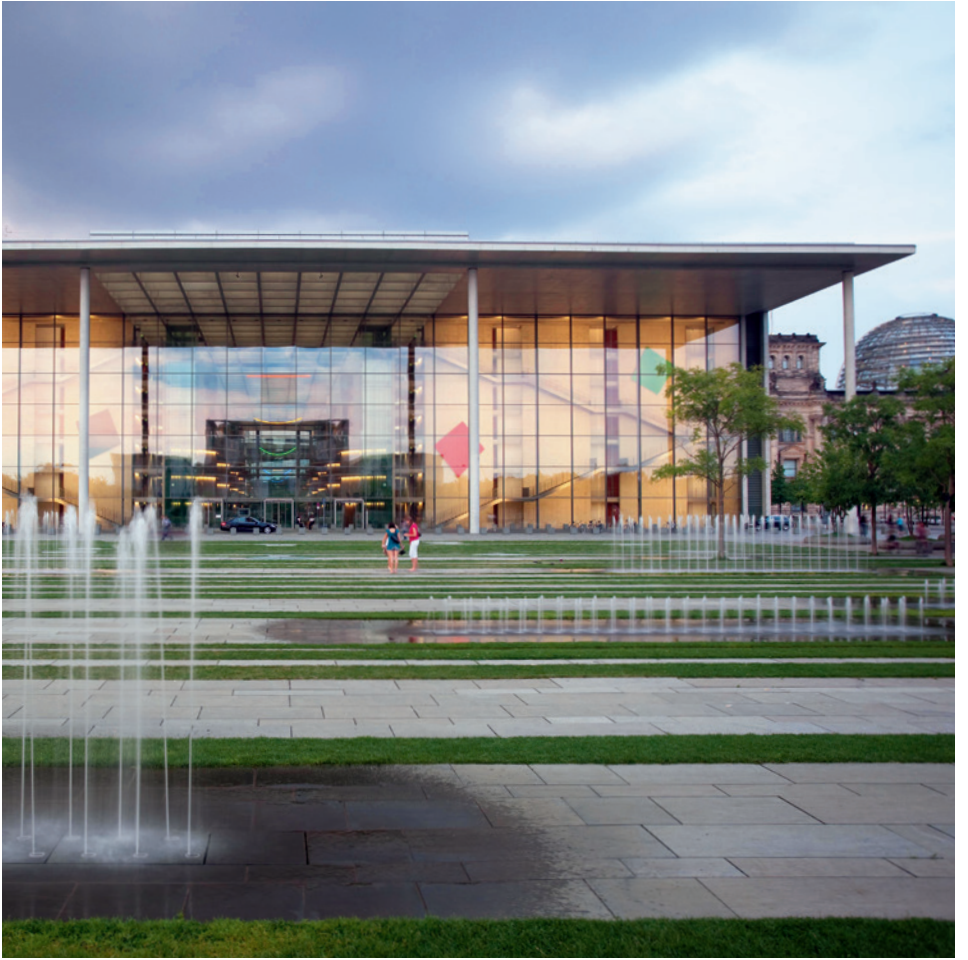
Davet eden açıklık: Paul-Löbe-Haus binasının batı girişi.
