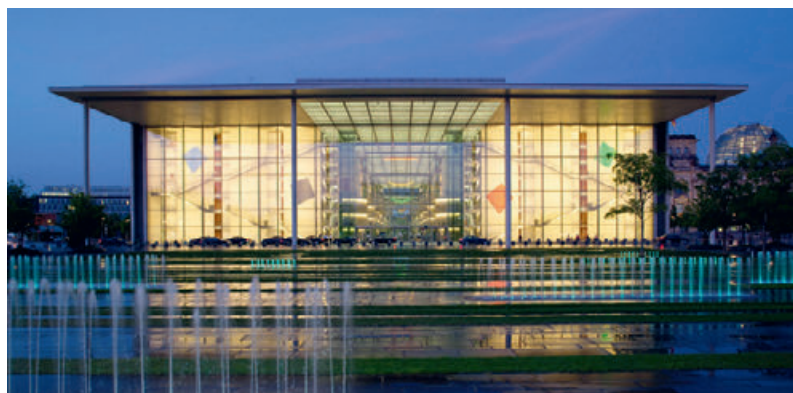
Гостеприимная открытость: западный вход в Пауль-Лёбе-Хаус.
