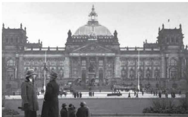
El edificio del Reichstag en el pasado: vista del edificio con la cúpula histórica del arquitecto Paul Wallot.
