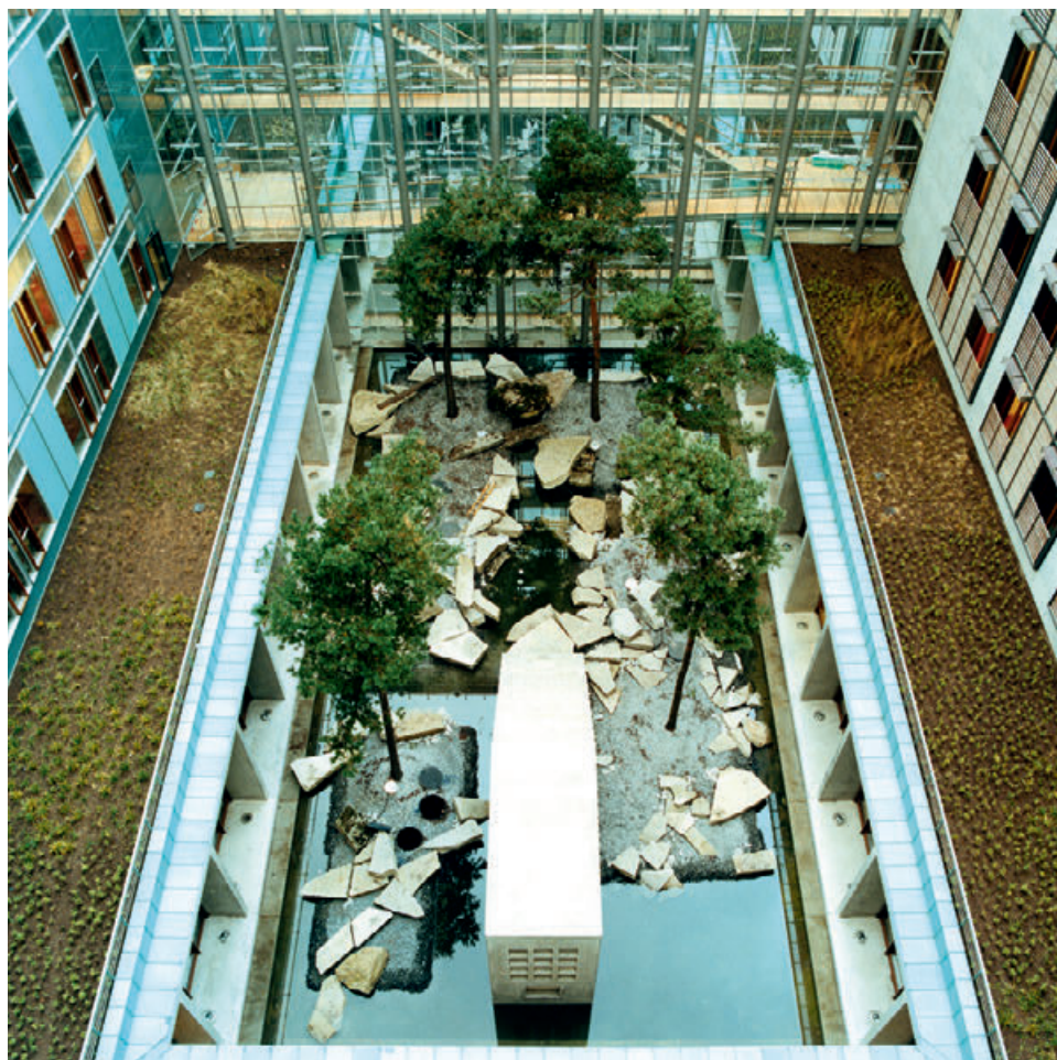
WES & Partner 2003 Patio del edificio 4
