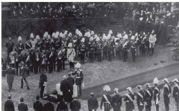
1884 r. – Cesarz Wilhelm I kładzie kamień węgielny pod budowę gmachu Reichstagu według projektu architekta Paula Wallota.
