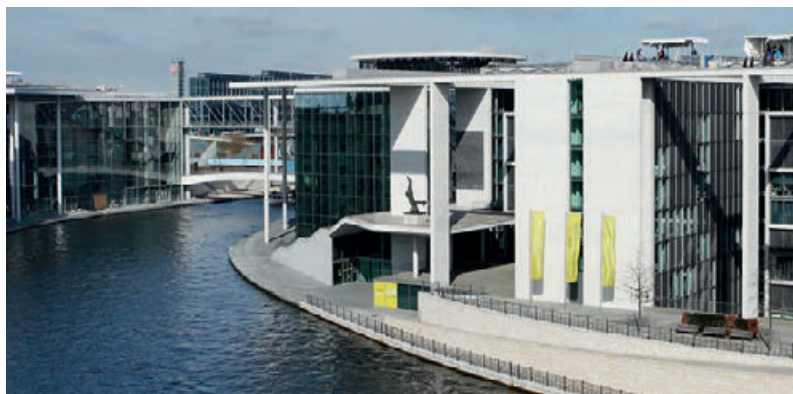
Skok przez Szprewę – dwie kładki dla pieszych łączą gmachy: Paul-Löbe-Haus i Marie-Elisabeth-Lüders-Haus.
