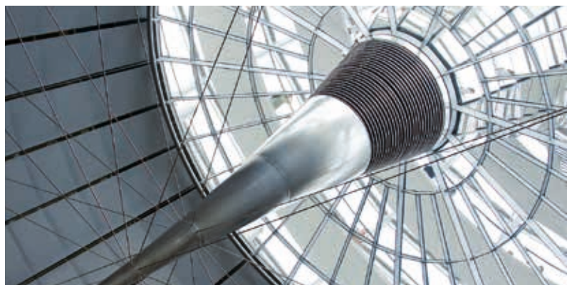
Luce e aria: attraverso la struttura a imbuto nella cupola del Reichstag la luce arriva nell'Aula, e l'aria viziata è aspirata ed espulsa all'esterno.
