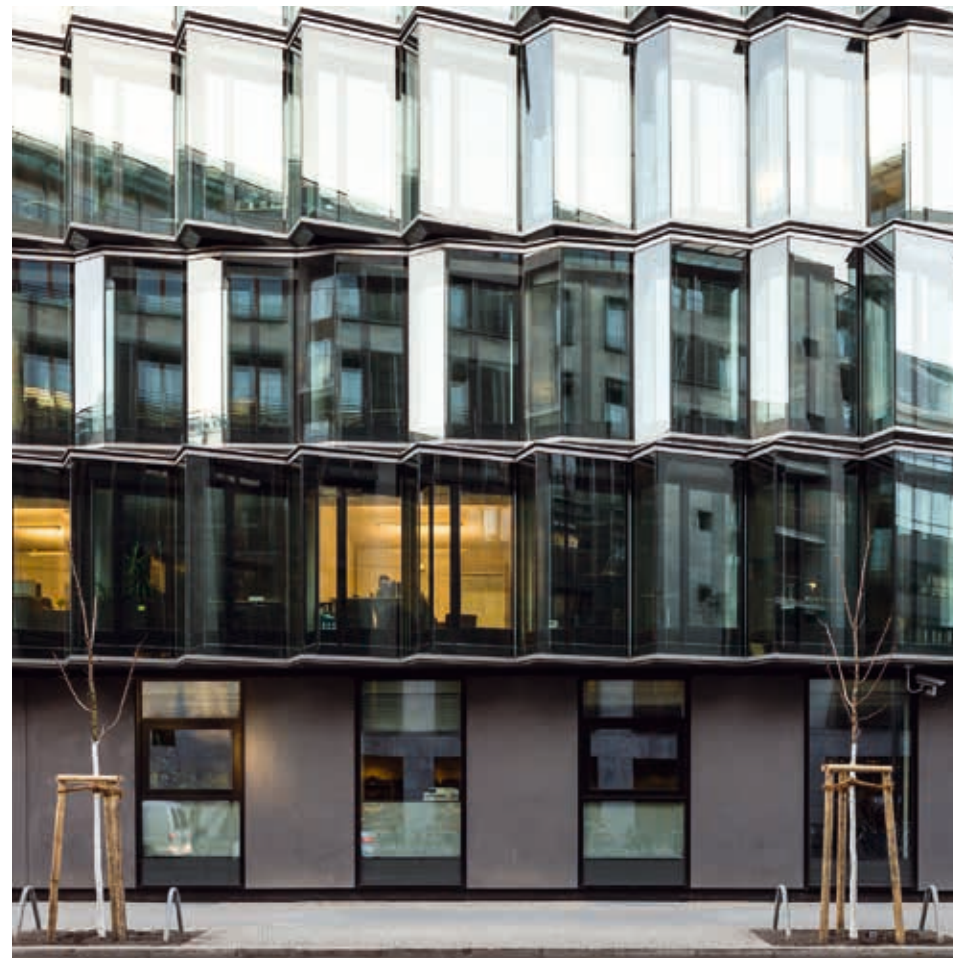
Sventrato e sopraelevato: l'edificio del Parlamento al numero 65 della Wilhelmstraße.
